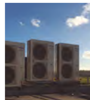
Rozwiązanie spełniające wymagania stawiane instalacji ogrzewania i chłodzenia. GE Aviation Bristol, Wielka Brytania. PACi
